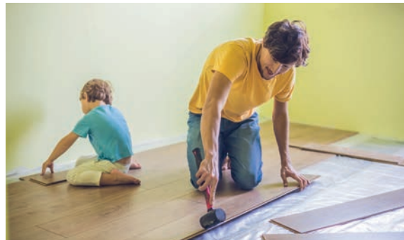
Kinderleichtes Verlegen nach Höhenausgleich mit Compensar.
